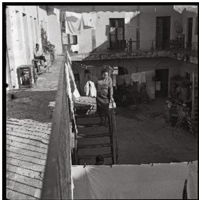
El conventillo del Medio Mundo en el barrio Sur de Montevideo donde tuvo su taller Carlos Páez Vilaró. Fue demolido en el año 2006. http://candomberos.blogspot.com/2011/03/el-conventillo-mediomundo.html .
